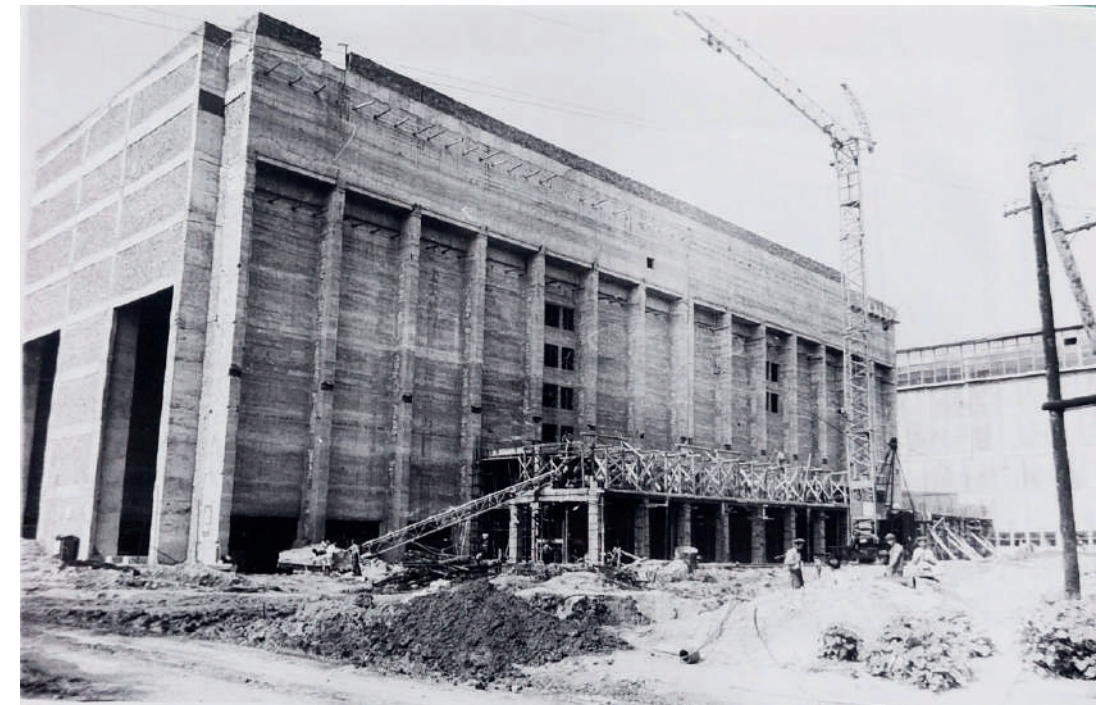
Vedere de ansamblu din perioada construcției Halei de Încercări LIT
